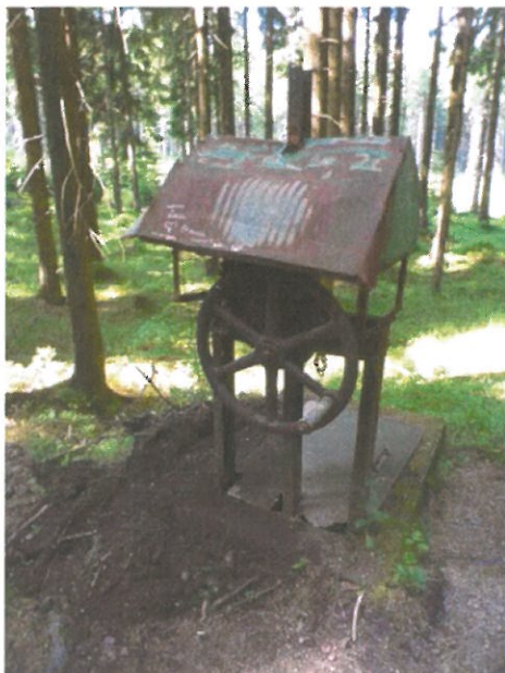
6. Přiváděcí objekt s výpustnou zátkou a přehrážkou na přítoku 0,750 km
