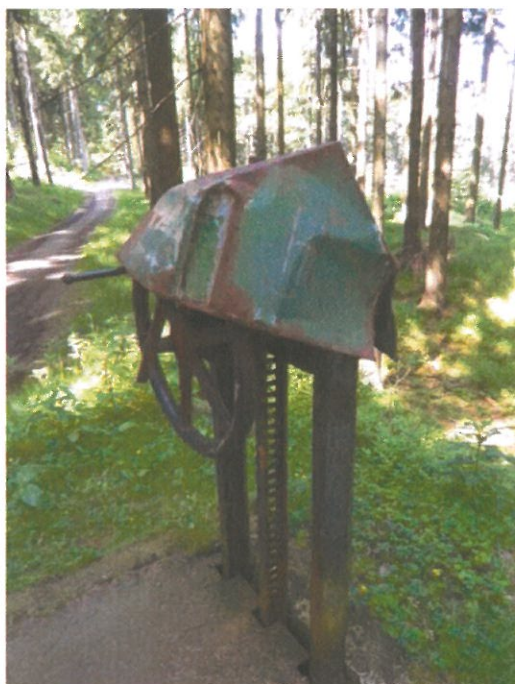
9. Vtoková šachta s výpustným stavidlem 1,650 km
