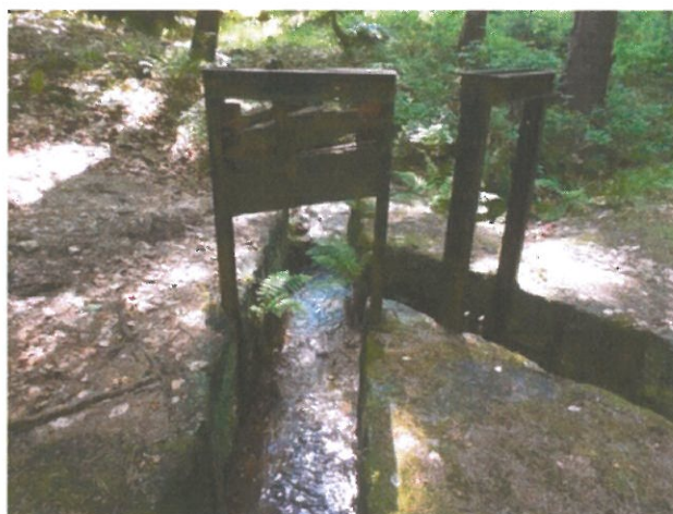
11. Přiváděcí objekt s přehrážkou na přítoku 2,400 km
