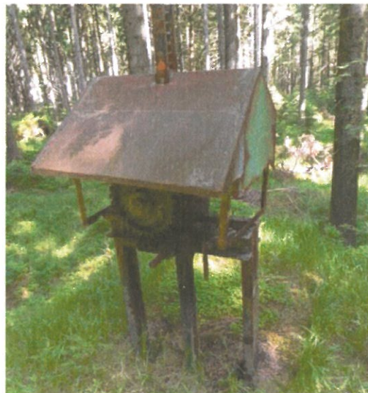
9. Vtoková šachta s výpustným stavidlem 1,650 km
