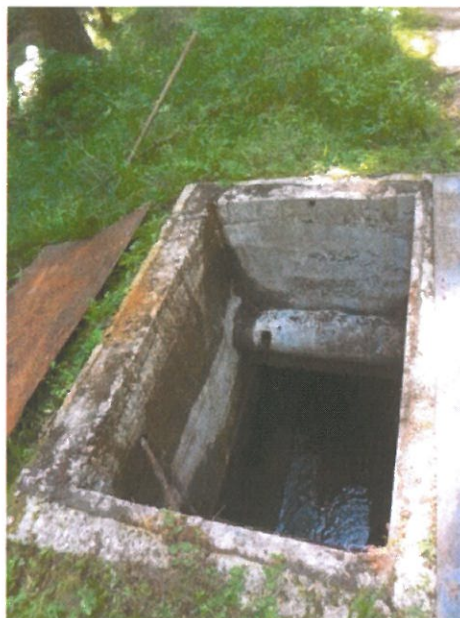
6. Přiváděcí objekt s výpustnou zátkou a přehrážkou na přítoku 0,750 km
