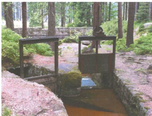
6. Přiváděcí objekt s výpustnou zátkou a přehrážkou na přítoku 0,750 km
